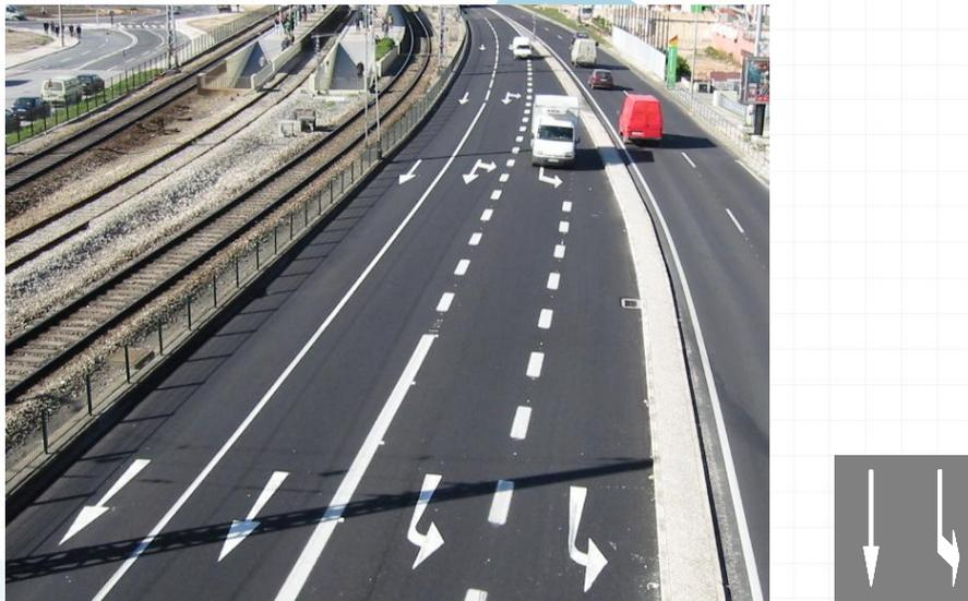
**Figura 2. 2** - Setas de selecção não regulamentares colocadas na sequência de setas regulamentares
