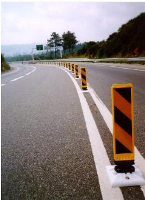
**Figura 14. 12** - Balizas do tipo O7a colocadas axialmente no IP5
